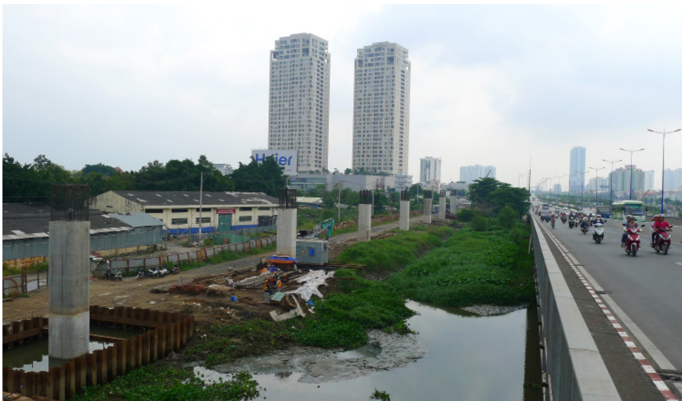
Figure 5 : Ligne n°1 de métro - phase de travaux génie civil, septembre 2014 (Cl. Musil)
