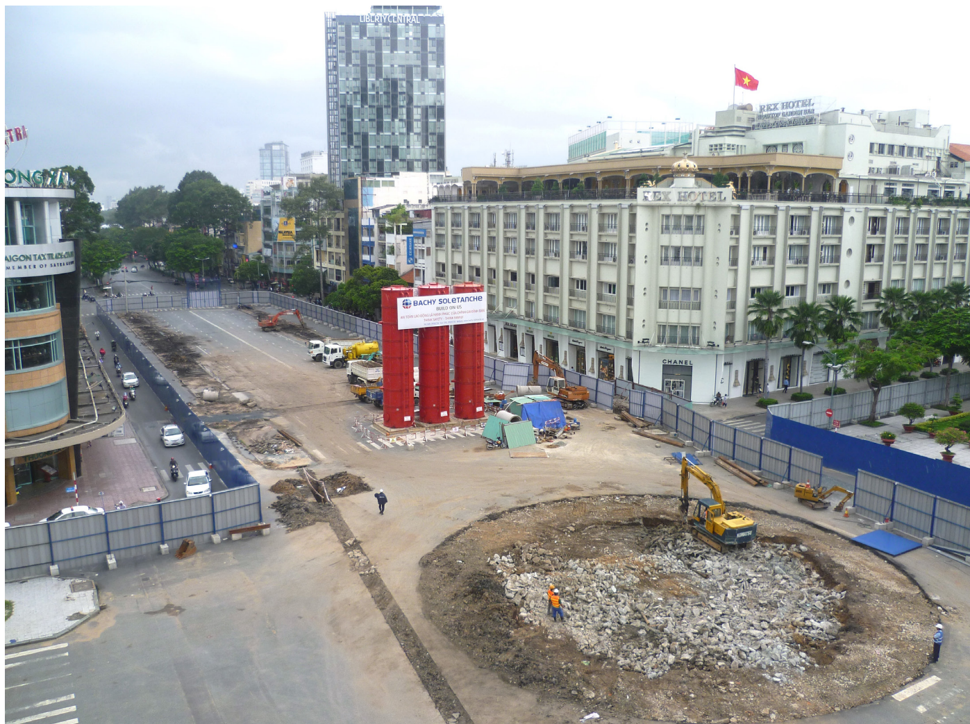
Figure 2 : Ligne n°1 de métro – 1 er district, préparation des travaux de surface pour la réalisation de la partie souterraine de la ligne, septembre 2014 (Ch. Simon)
