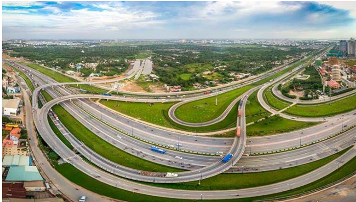
Nút giao thông ngã 3 Cát Lái (quận 2) nằm ở điểm cuối của đại lộ Đông Tây kết nối với xa lộ Hà Nội mở rộng. Đây là tuyến đường quan trọng bậc nhất khu vực cửa ngõ phía đông nối TP HCM với các tỉnh Đông Nam Bộ và miền Bắc. Công trình được xây dựng với hai cầu từ cảng Cát Lái (Nguyễn Thị Định) và đại lộ Mai Chí Thọ) rẽ trái về trung tâm Sài Gòn, một cầu hướng từ quận Thủ Đức rẽ trái về cảng Cát Lái, hầm Thủ Thiêm và 7 nhánh đường phía dưới. Ảnh: Henry Lee
